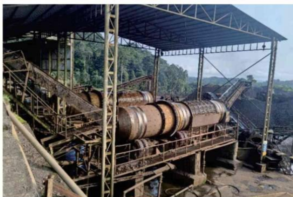
加蓬共和国 蒙贝利锰矿生产线 Manganese Ore Processing Line, Mombélé, Gabon
