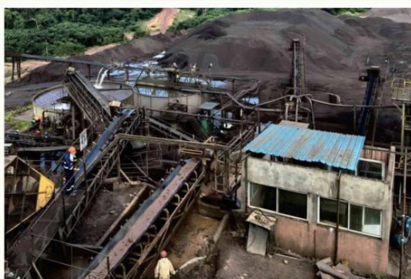
加蓬共和国 奥孔贾锰矿生产线 Manganese Ore Processing Line, Okondja, Gabon
