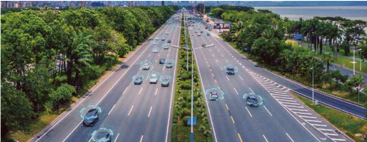
应用领域: 广泛应用于交通路口、路段、高速、隧道、园区、全息路口。
