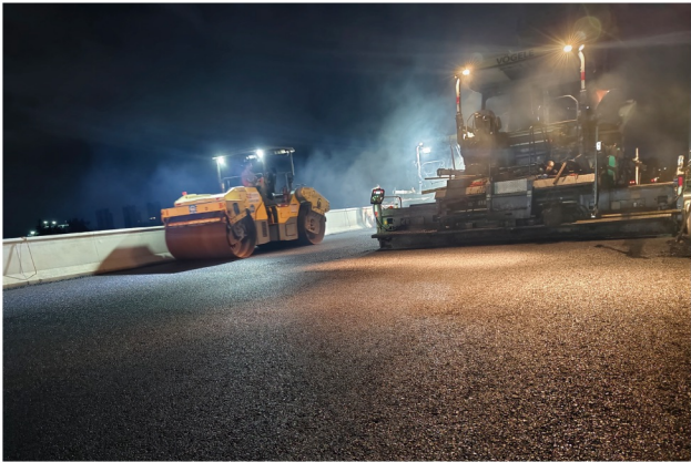
中铁三局二公司 广州白云（棠溪）站综合交通枢纽一体化建设工程项目
