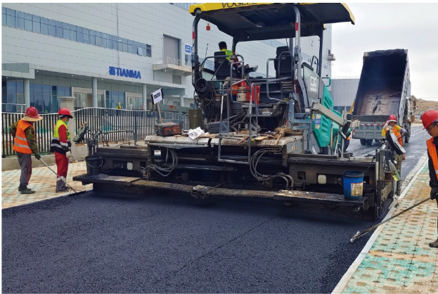
中建一局 厦门天马显示科技生产线项目
