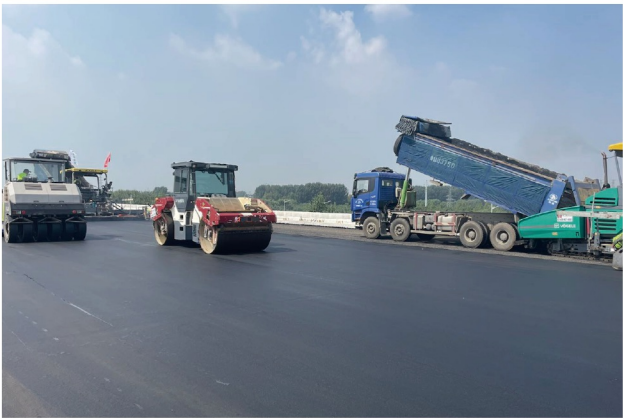
中建六局、中铁十局 青岛204大沽河桥梁工程项目
