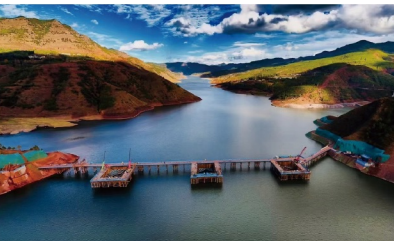
毛家村水库特大桥围堰项目
