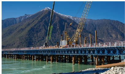
西藏米林县雅鲁藏布江特大桥项目
