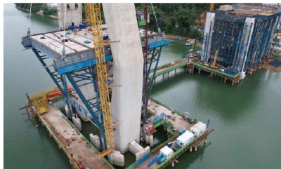
上横高速公路西津郁江大桥边梁钢支架工程项目
