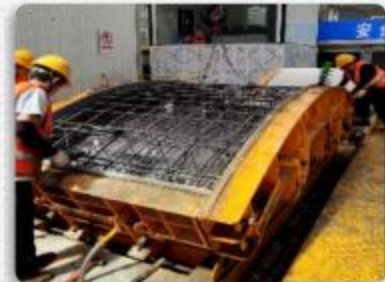
Pipe Segment Line 管片生产线
