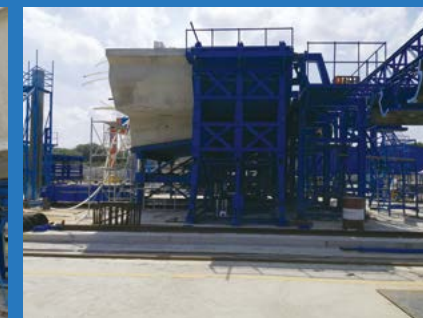
中建八局宁句城际节段梁模板 -1
