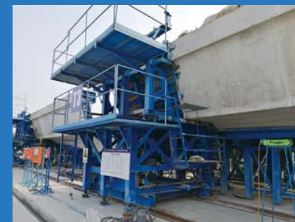
中铁十八局天津 Z4 线节段梁模板 -2
