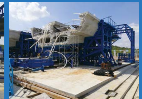
中建八局宁句城际节段梁模板 -2
