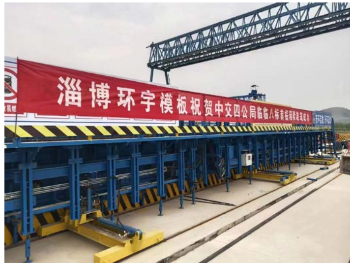
中交四公局临八标液压公路箱梁模板
