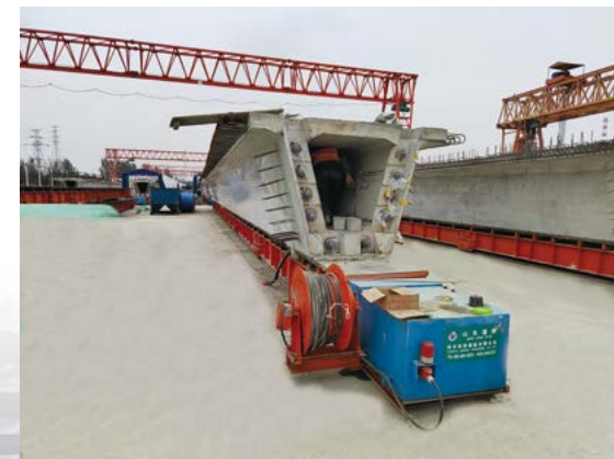
山东路桥济微高速 - 公路箱梁生产线
