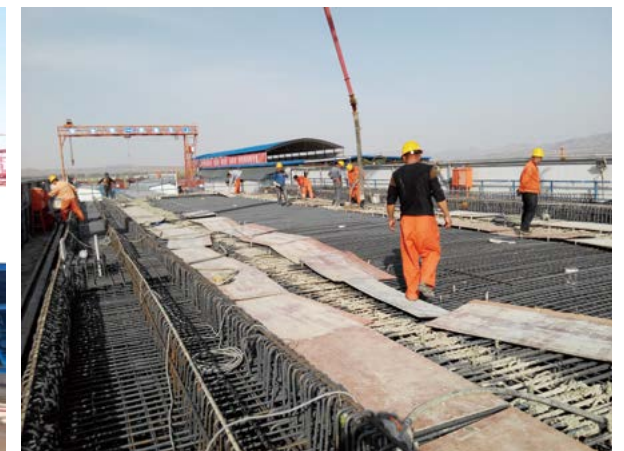
组拼中的铁路液压箱梁内模
