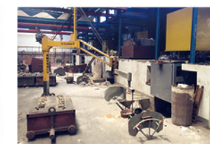
中频感应电炉 Pouring System
