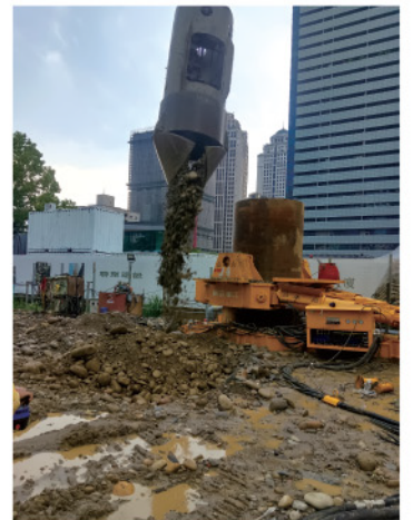
臺中七期豐邑塔工地
