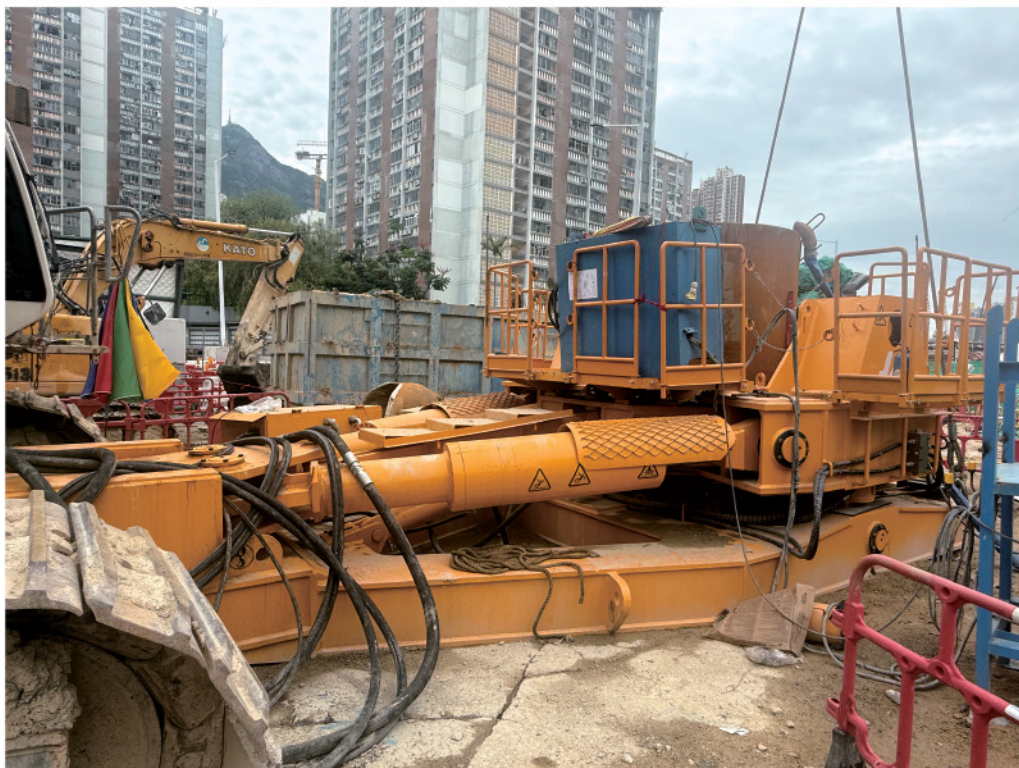
香港屯門河工地
