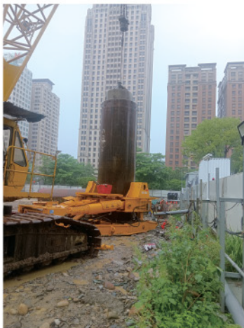
臺中七期豐邑塔工地
