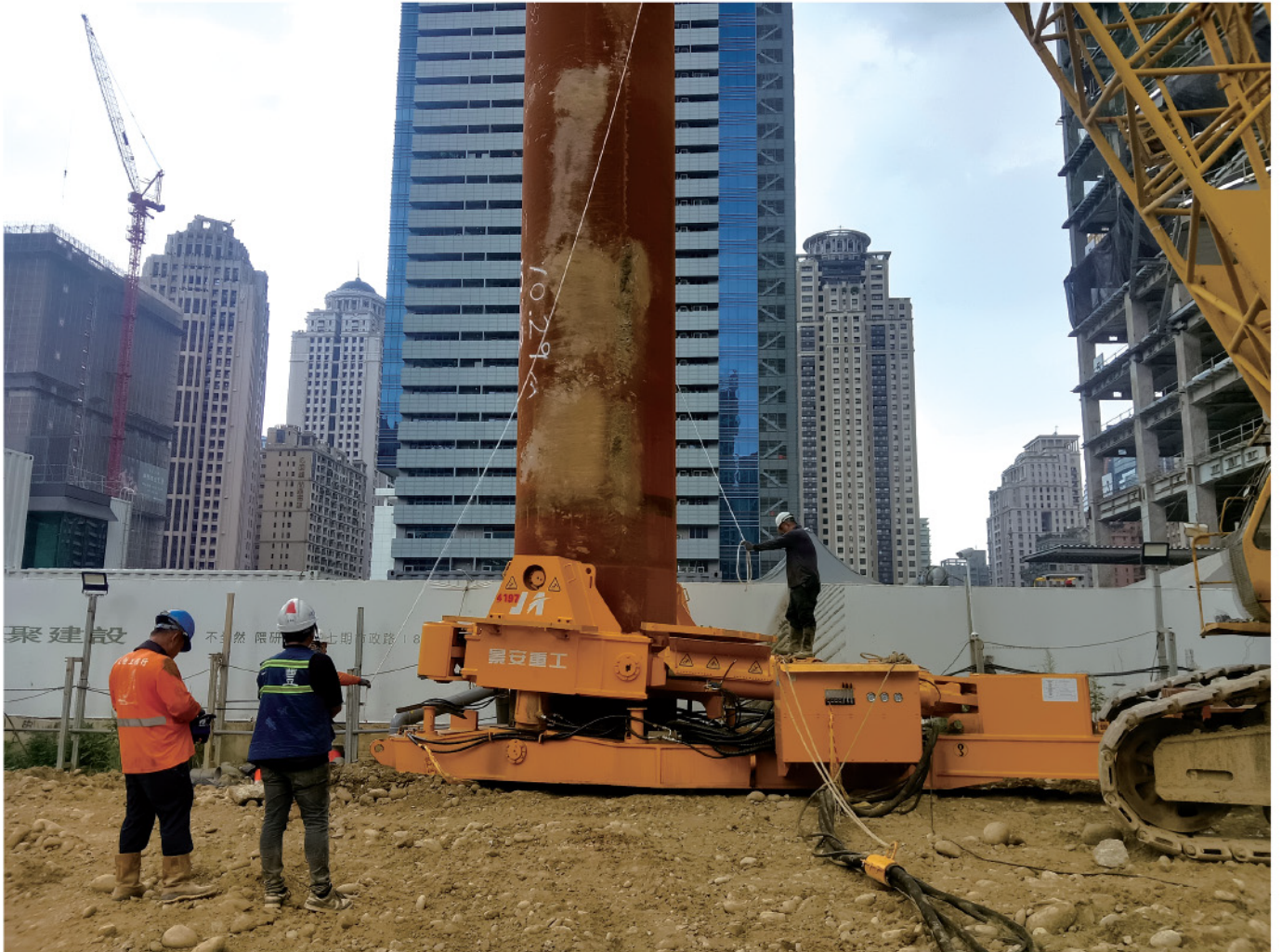
臺中七期豐邑塔工地
