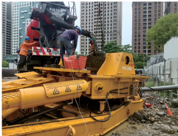
臺中七期豐邑塔工地
