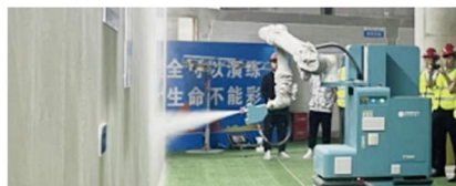
中建一局湖州奥青汇基础设施项目
