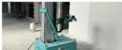
中建八局上海徐汇金融城项目
