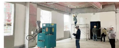
北京建工北京房山棚户区改造项目
