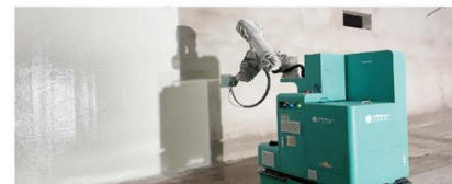
上海建工桃浦智创城606地块项目
