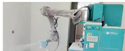
北京建工北航宿舍楼修缮项目
