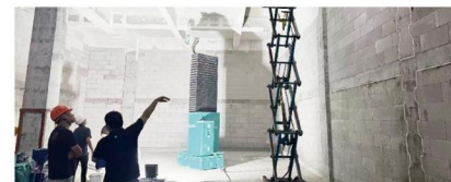
浙江建工建设银行档案数据中心项目
