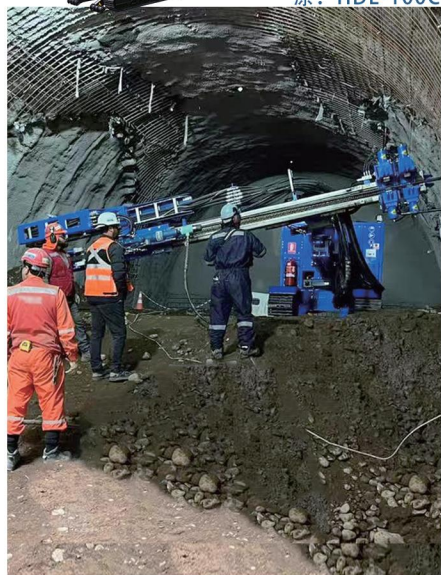
海外隧道超前注浆
