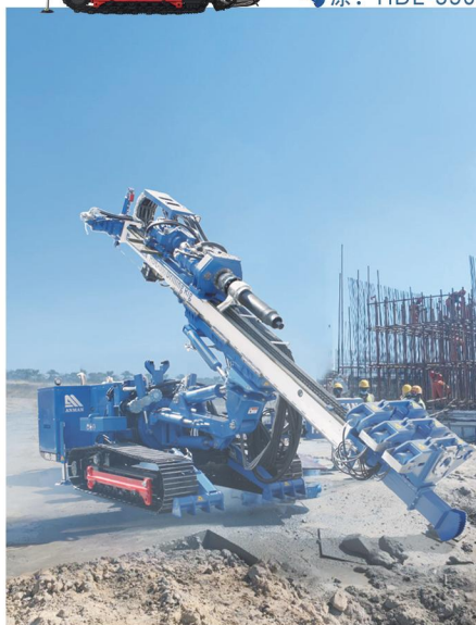
海外注浆引孔
