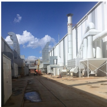
徐工集团巴西抛丸线滤筒除尘项目 XCMG Blasting Line Cartridge Dust Collector in Brazil
