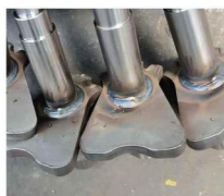
气保焊角焊缝
