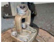
锻钢阀支架焊接
