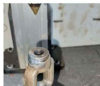
锻钢阀支架焊接
