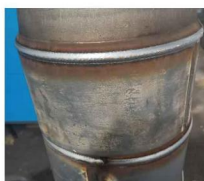
管管对接气保焊
