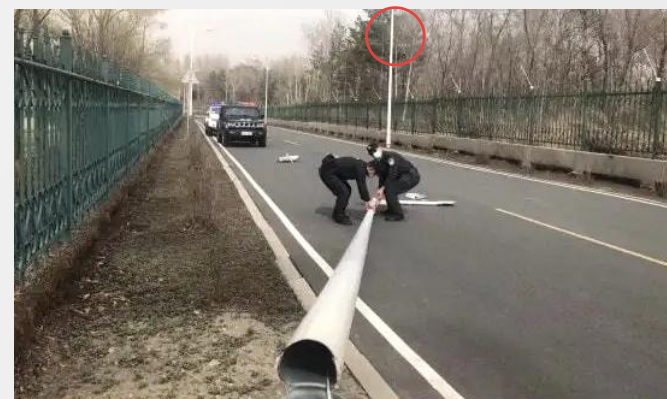
路灯、电线杆、广告牌倾斜安全监测
