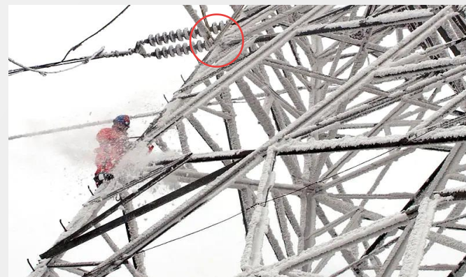
高压线缆除冰、绝缘子端、电力塔监测
