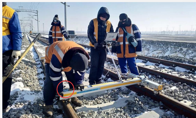
高铁轨距水平测量
