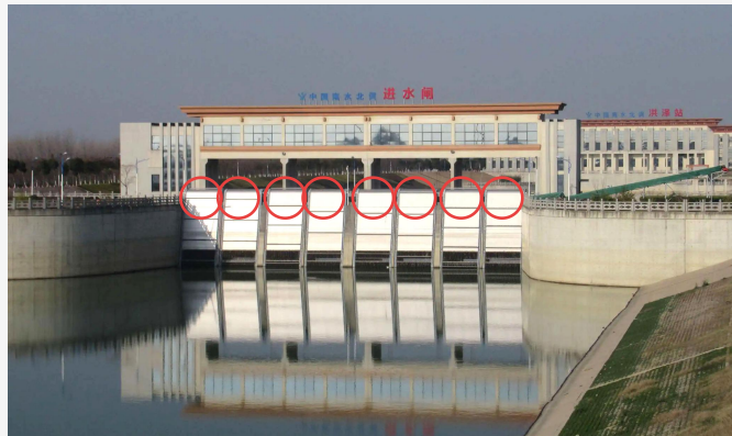
水闸门开关角度控制
