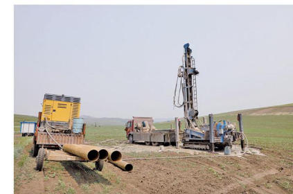
菲律宾潜孔钻车农田灌溉水井260米
