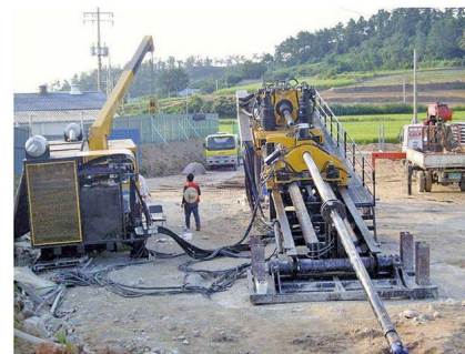
西安未央段天然气管道工程穿越长度500米
