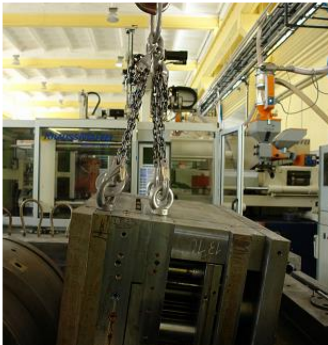
吊环螺丝与起吊受力方向不一样 ....
