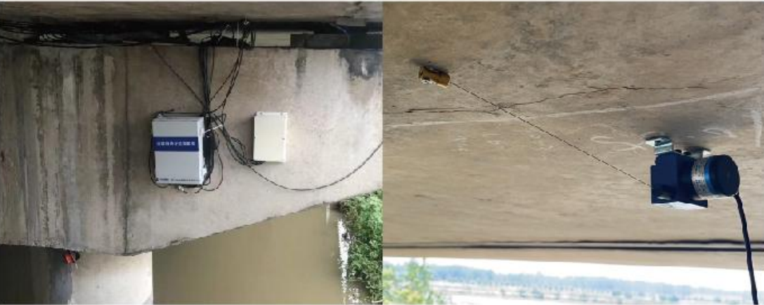
湖北黄黄高速公路桥梁健康监测项目
