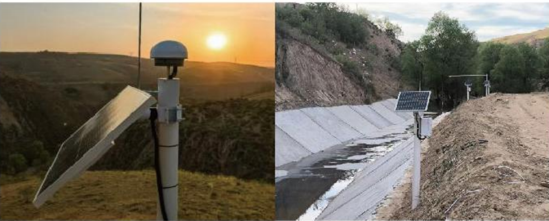
边坡表观位移监测项目
