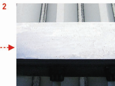
使铁面露出清洁的金属面
