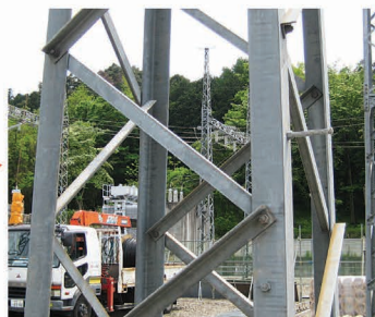
涂装前铁塔的状态 表面只有白锈，没有产生红锈。
