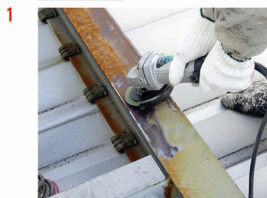
使用电动工具去除铁锈，旧涂膜
