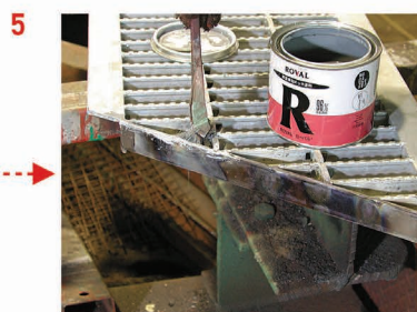
焊接部和钢条上涂装罗巴鲁（涂刷2道）
