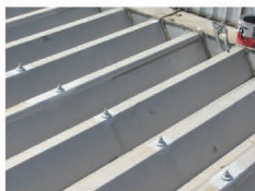
钢板屋顶的螺栓部分
