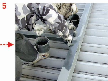
涂刷30-60分钟后，确认表面是否干燥。 再涂刷第二道。
