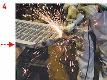
使用电动工具平整焊接部
