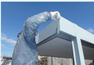
医院大楼钢结构
