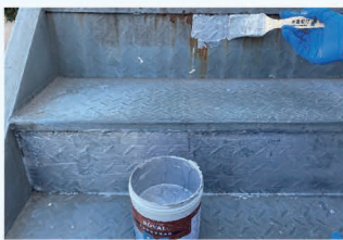
钢结构楼梯翻新
