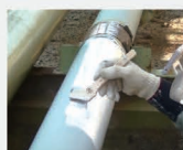
施工现场 正在环氧罗巴鲁上涂刷面漆
