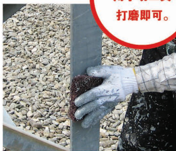
手工除锈 使用手动工具将表面白锈，污垢去除。
