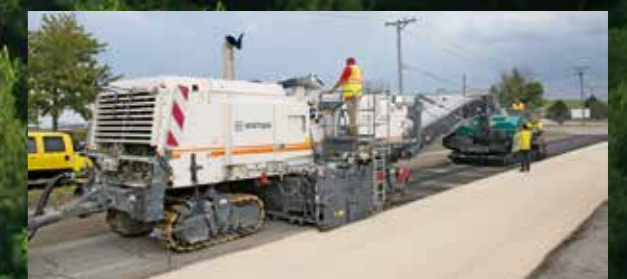
2013 基于同步摊铺的泡沫沥青就地冷再生工艺 3800 CR 问世
