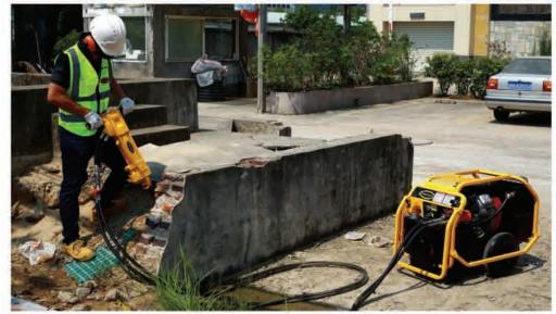
HCD10手持式液压岩芯钻可在水泥混凝土、钢筋混凝土、沥青混凝土、岩 石上钻孔或进行岩芯取样,设计的D型手柄可水平在墙体上开孔。它也是 建筑施工和家装行业中的好帮手。
