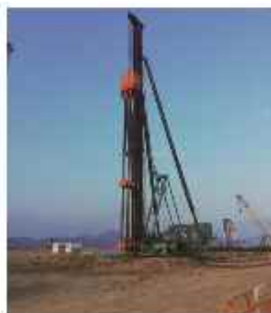
陆上工程 Land engineering
