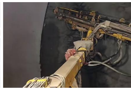
全方位无死角作业
