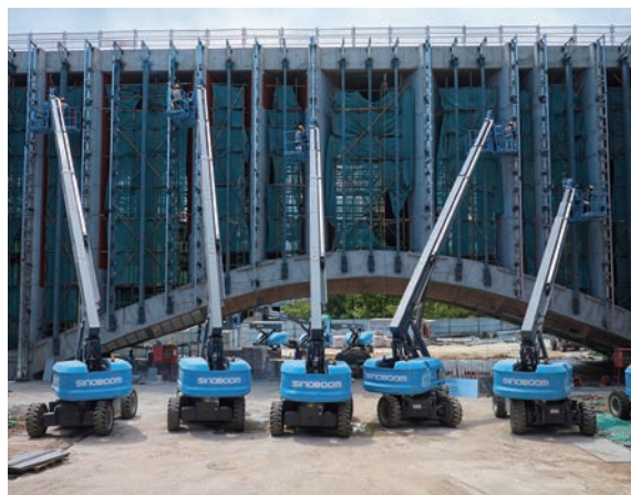
中科院大学建设
