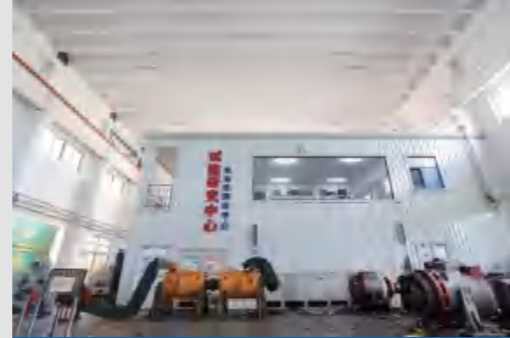
电机综合试验中心 Motor Comprehensive Testing Center
