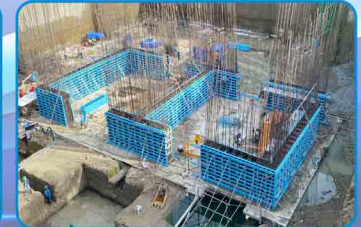
7 组合式墙体模板 Wall Formwork
