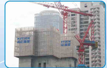
7 组合式墙体模板 Wall Formwork
