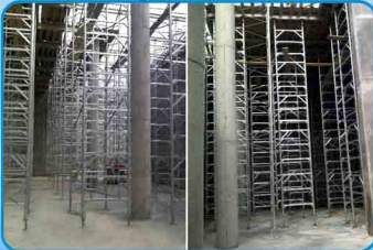
11 塔式支撑架 Shoring Frame
