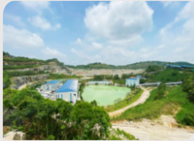
广东·广州-顺兴石场年产300万吨制砂线
