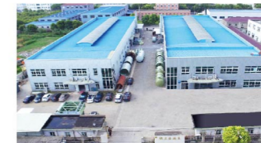
玻璃钢风机厂区
