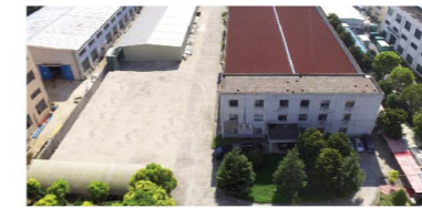
空调风机厂区
