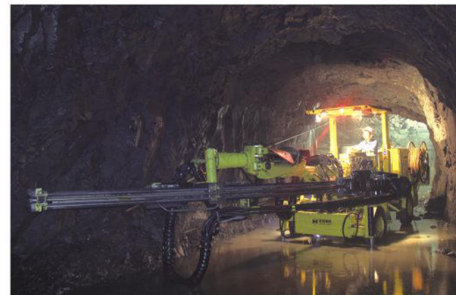
CYTJ76A掘进钻车井下作业
