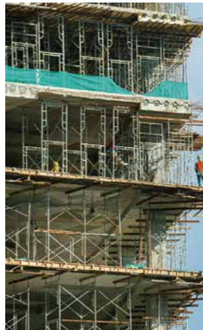
建筑 旧建筑拆除、钢筋混凝土破碎、船舶船体除锈、除锈
