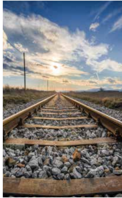
铁路 开山、隧道挖掘、道桥拆毁、路基夯实
