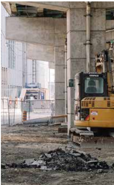
市政园林 混凝土破碎、水、电、气工程施工、旧城改造
