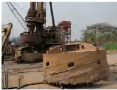
深江铁路项目 Shenzhen-Jiangmen Railway Project
