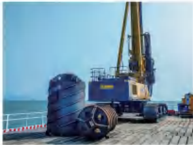
黄茅海跨海通道项目 Huangmaohai Cross-sea Passage Project
